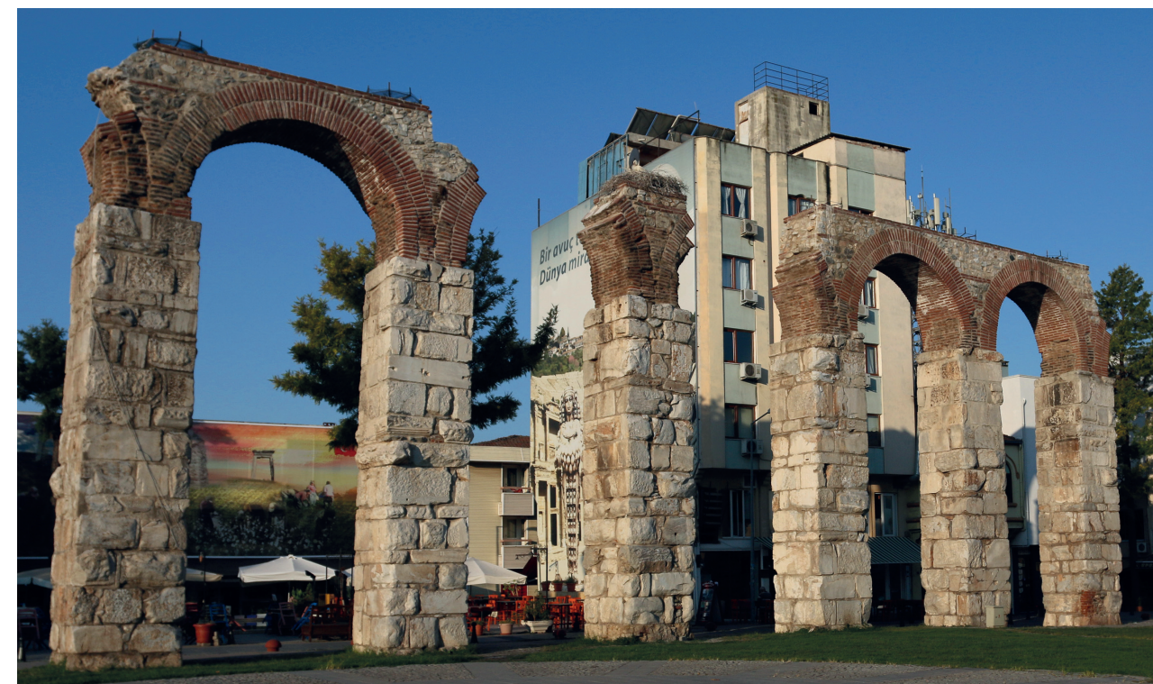
Abb. 2 a: Byzantinischer Aquädukt in Selçuk, Aquädukt Pfeiler aus großformatigen Marmorspolien (© ÖAI-ÖAW/L. Zabrana)
